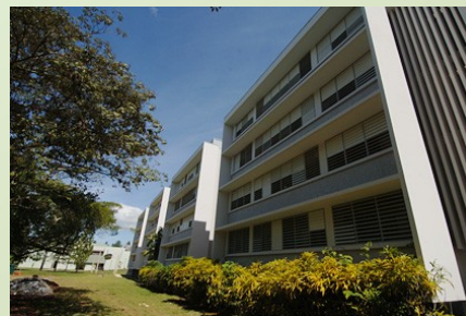
Edificio de Oficinas de Profesores
