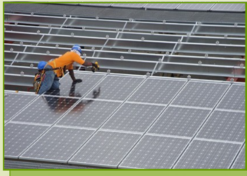
Construcción del Parque Solar del Complejo Onofre Carballeira Umpierre en Bayamón
