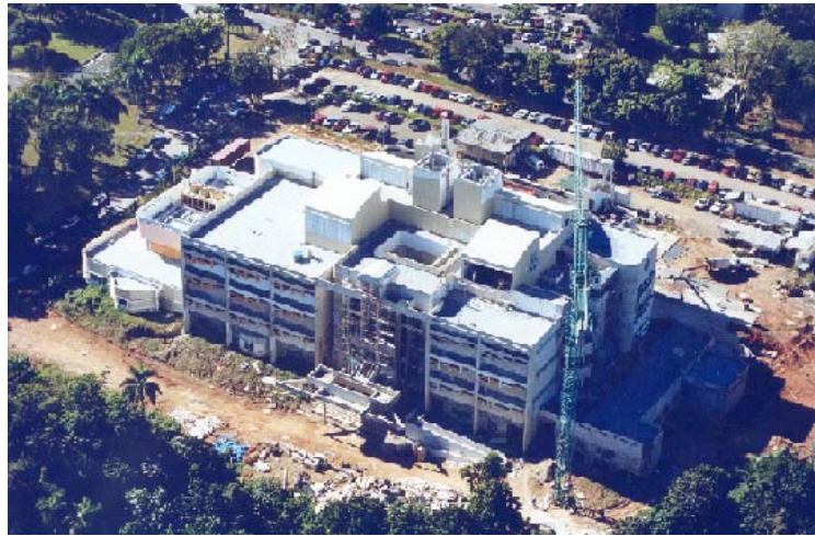
Nuevo Edificio de Biología
