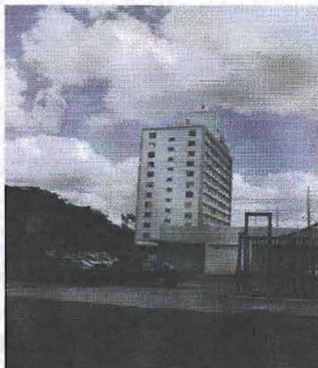
Figura 43: Mejoras al Edificio Darlington
